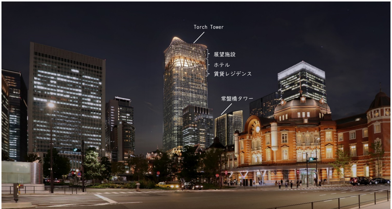
▲街区完成時の TOKYO TORCH Park 全景 (東京駅側より)
